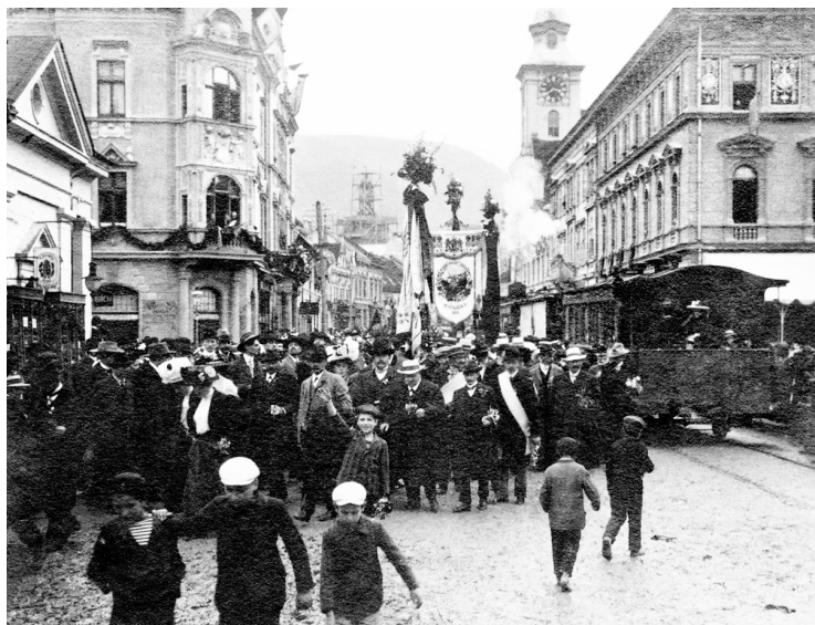
Defilare a unor cluburi pe Strada Vămii, 1910
